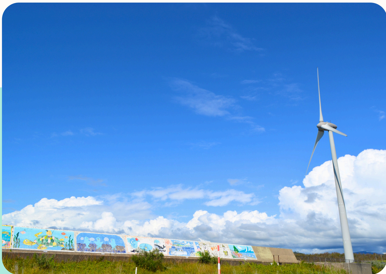
本荘港 みなとオアシス画廊と風車:職員撮影
